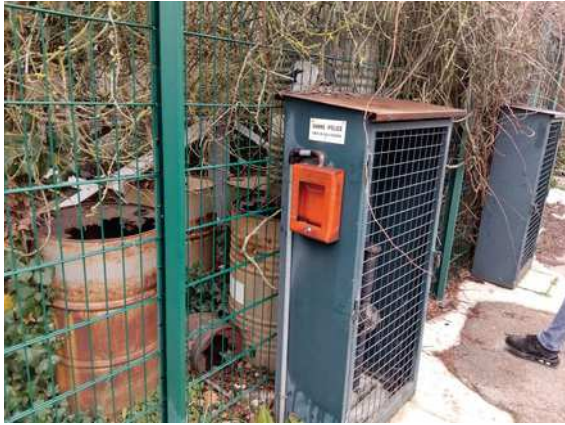
Aire grillagée et dépotage fioul
