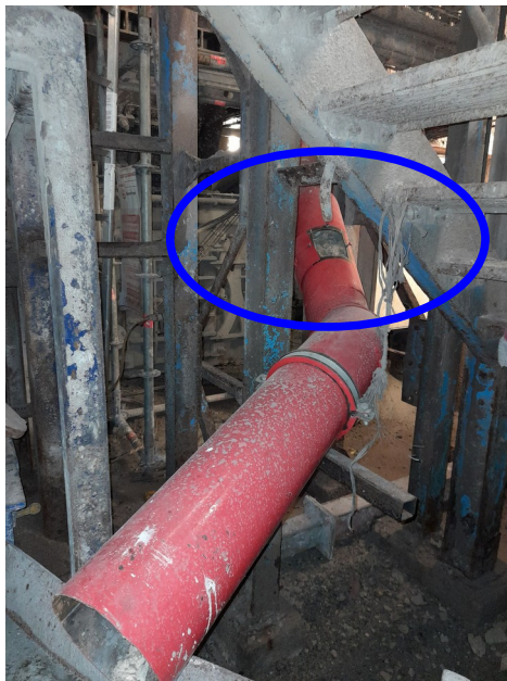
Bouchage de la sortie de crible du four n°2
