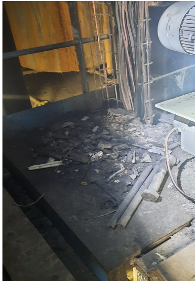
Nettoyage de la zone du sinistre du four 3
