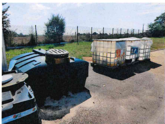
Cuve à huiles usagées et caisse de stockage de déchets dangereux devant le local DMS
