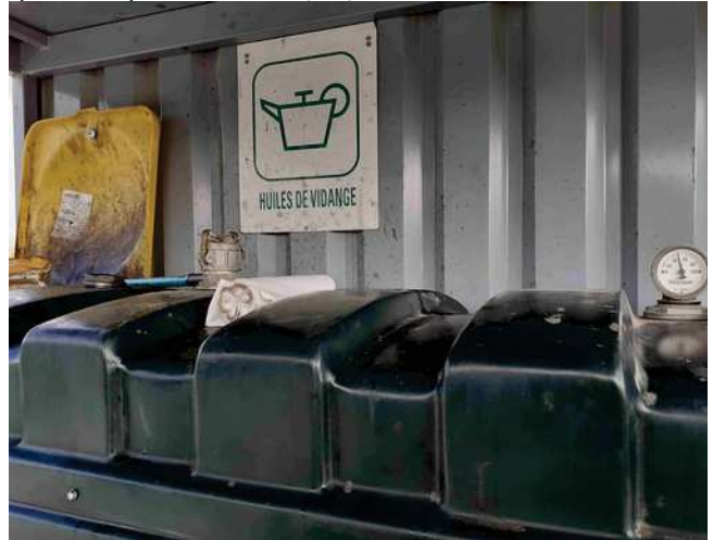
Local Stockage des huiles : conteneurs huiles de vidange (vert foncé) et huiles de friture (bleu), rétention métallique et jauge de niveau du conteneur des huiles de vidange Photographies prises par l'équipe d'inspection le 18/10/2024
