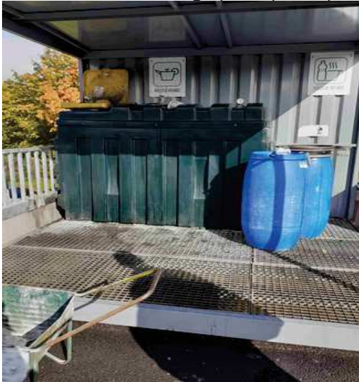
Local Stockage des huiles : conteneurs huiles de vidange (vert foncé) et huiles de friture (bleu), rétention métallique et jauge de niveau du conteneur des huiles de vidange Photographies prises par l'équipe d'inspection le 18/10/2024
