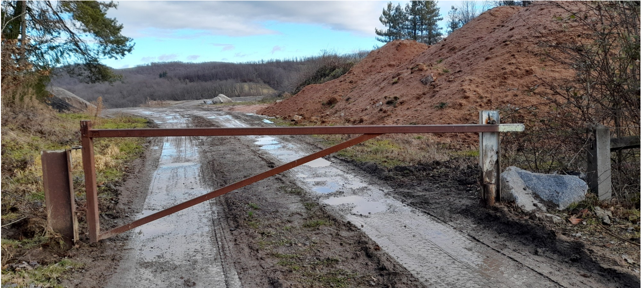
Figure 1: Limitation de l'accès au site
