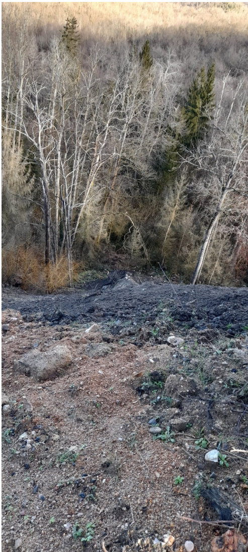
Figure 4: Hauteur du massif de déchet estimée entre 15 et 20 mètres
