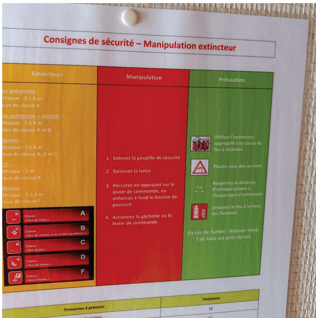
Figure 7 : Consigne de sécurité - Manipulation des extincteurs
