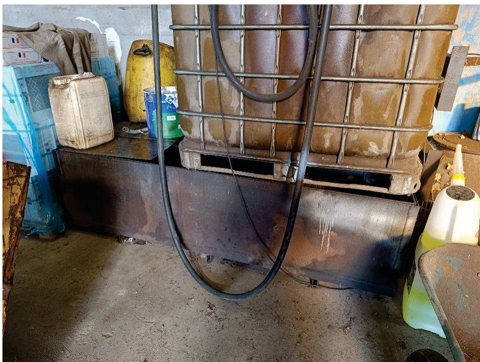
Figure 2 : Cuve de fuel de 1 000 L sur rétention de 1 200 L
