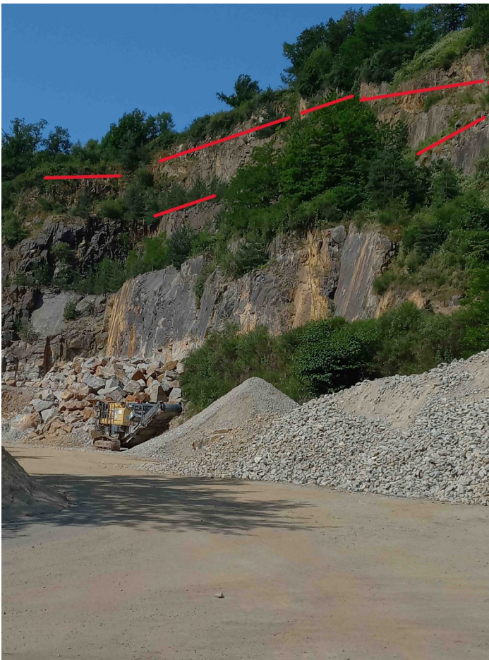
Ligne de crête de gradins à purger
