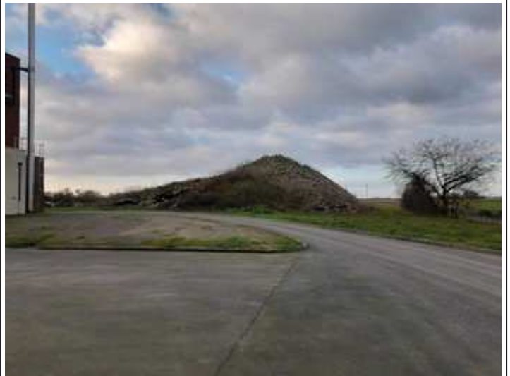
Cf point 19 : Tas de gravats issus de la démolition de la touraille T5
