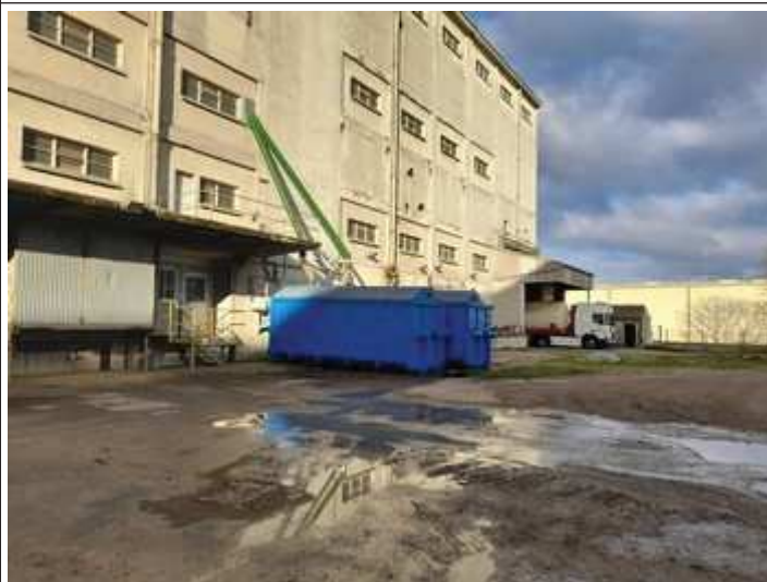
Cf point 10 : Installation définitive suite incident boisseau pellet (pas en exploitation)
