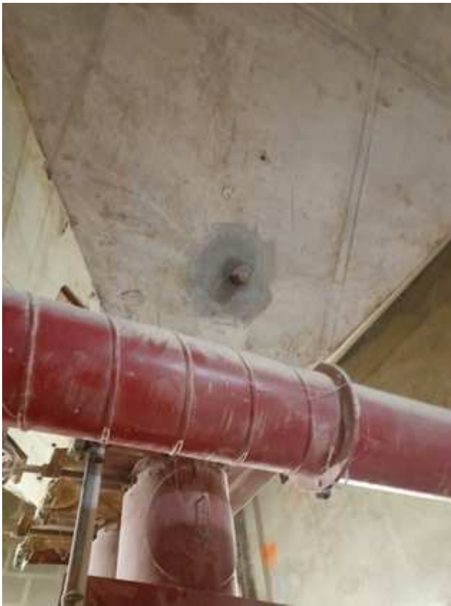
Cf point 13 : Dispositif d'inertage des cellules de malt
