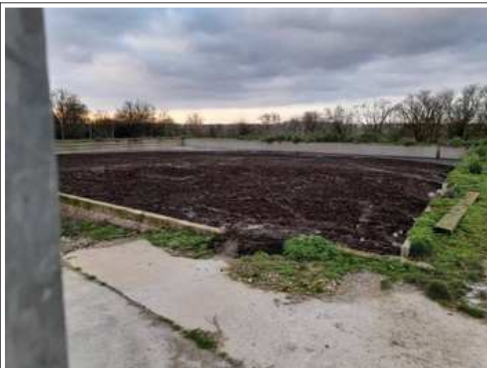
Cf point 20 : Cahier de suivi de la STEP - Bassin à boues
