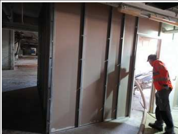
Cf point 10 : Installation provisoire suite incident boisseau pellet
