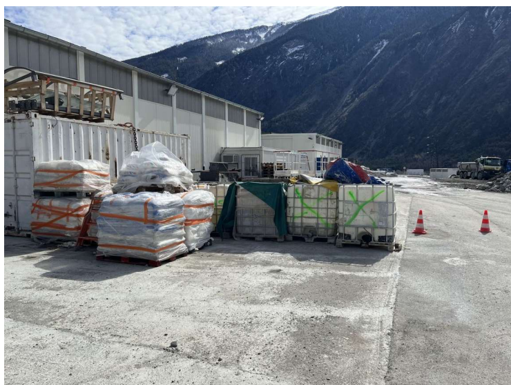
Stockage GRV SIKA en attente d'enlèvement (résidus de produits, stockés sur aire étanche)
