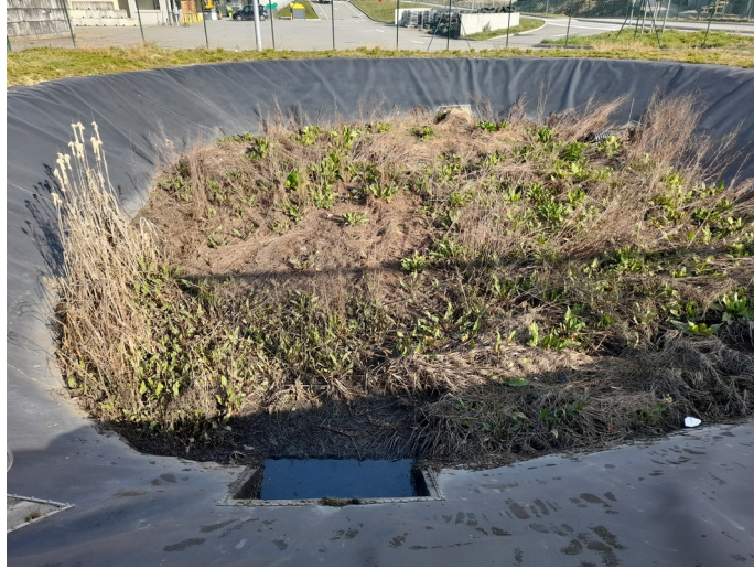
Bassin de rétention
