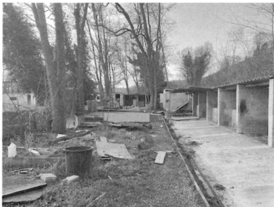
Chenil-vue d'ensemble fond
