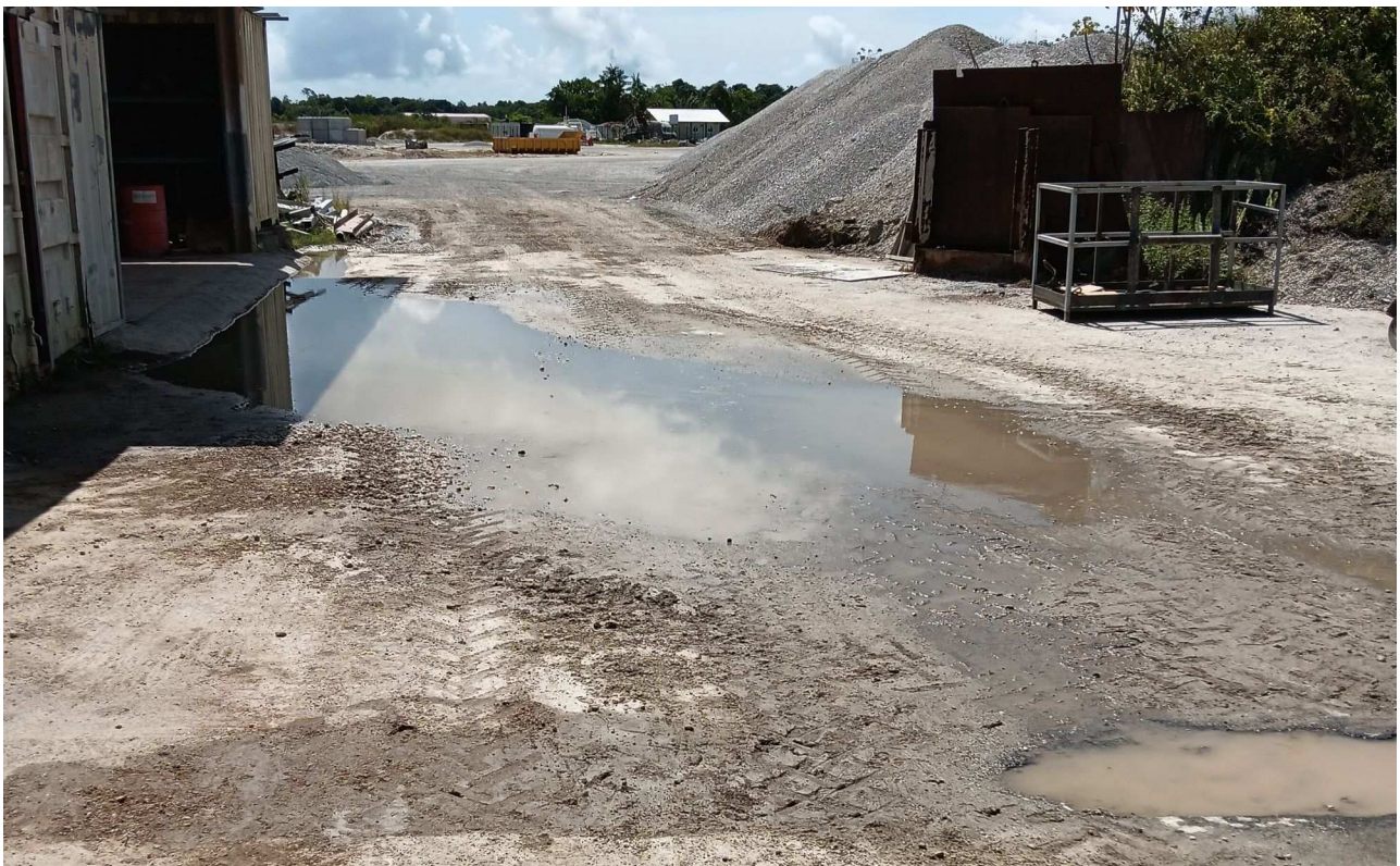
zone boueuse sur voie de circulation regard bouché
