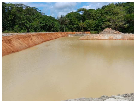
Bassin de décantation intermédiaire
