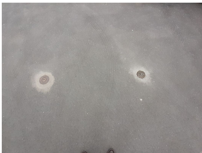
Sondages de sol rebouchés
