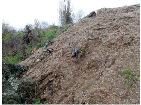
Bâches en remblais
