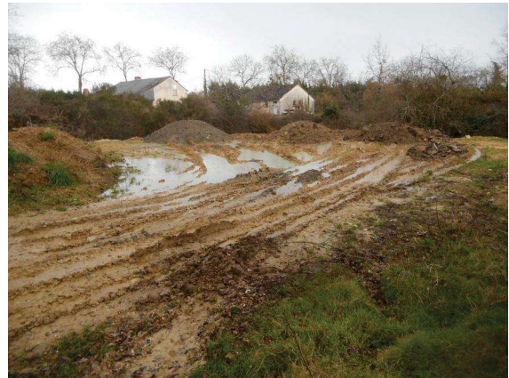
Aménagement du chemin du voisin
