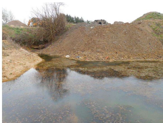
Remblais récents de l'excavation et fourreaux en plastique en pied
