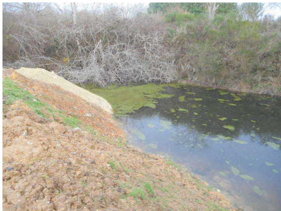
Aménagement du chemin du voisin
