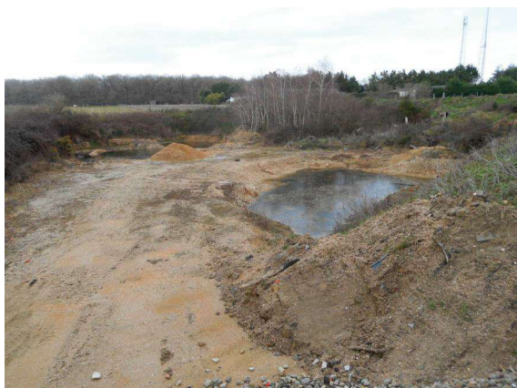
Vue sur l'excavation depuis la rampe sud-est
