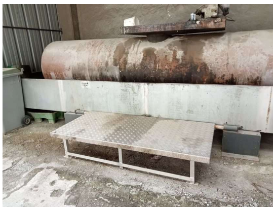
Citerne d'huiles usagées (à gauche) et sa rétention encombrée (à droite)
