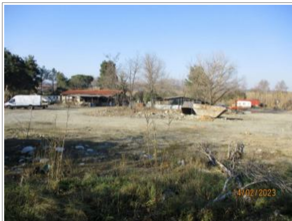
Des déchets et produits inflammables sont toujours présents sous l'avancé du toit du bâtiment type hangar
