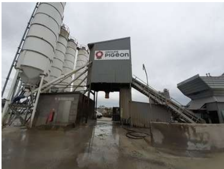
Centrale de fabrication de beton
