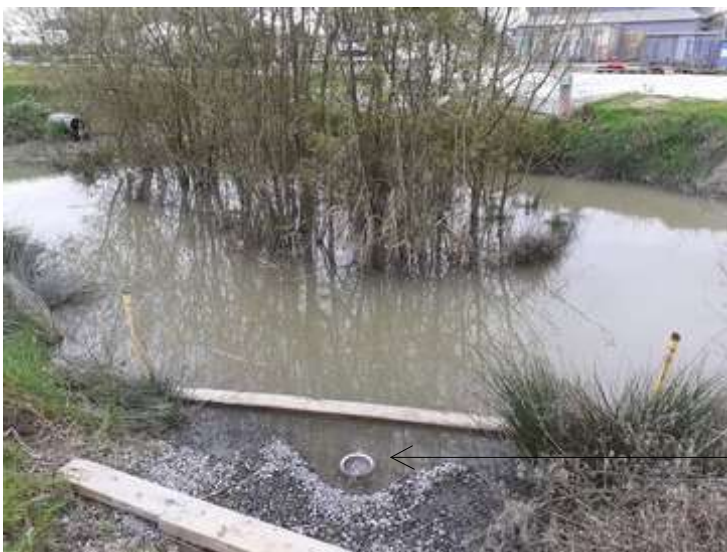
Bassin de récupération des eaux pluviales
