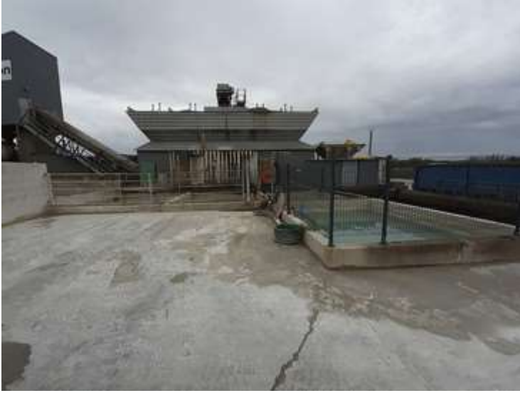
Plateforme de travail pour l'élaboration du beton
