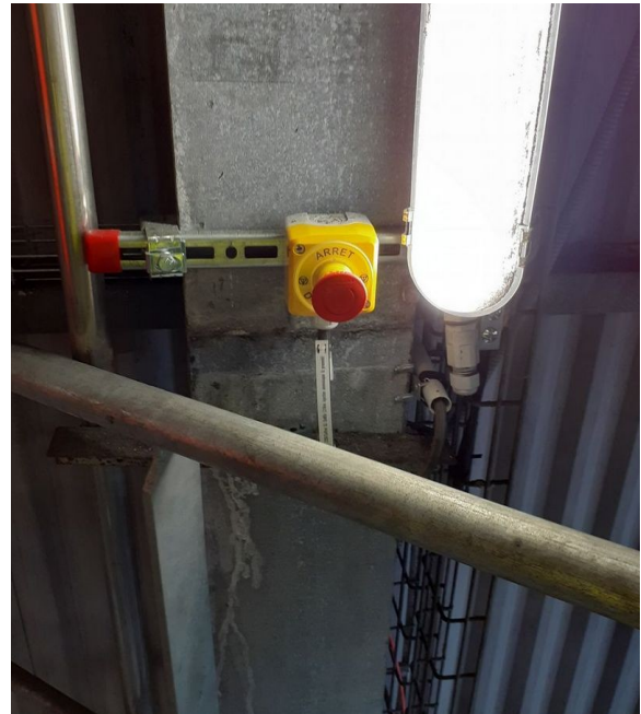
Bouton d'arrêt d'urgence de l'injection d'ammoniaque
