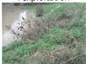
sortie de tuyau des eaux pluviales de l'exploitation
