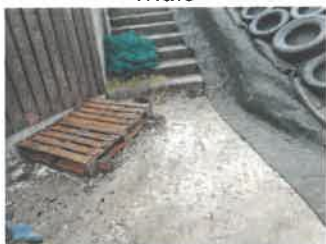
escalier accès silos à maïs
