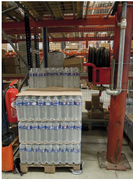
RIA de la cellule de stockage logistique non manœuvrable
