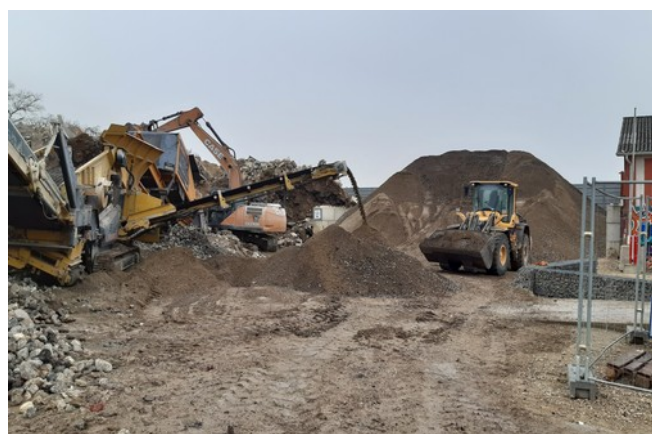
Concasseur et tas de matériaux fin
