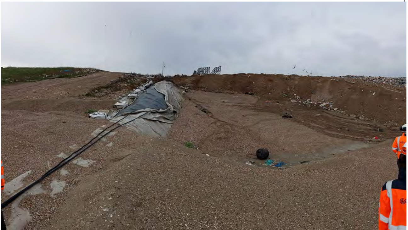
Diguette sud et front de déchet recouvert de matériaux inertes (vue du bas du casier)
