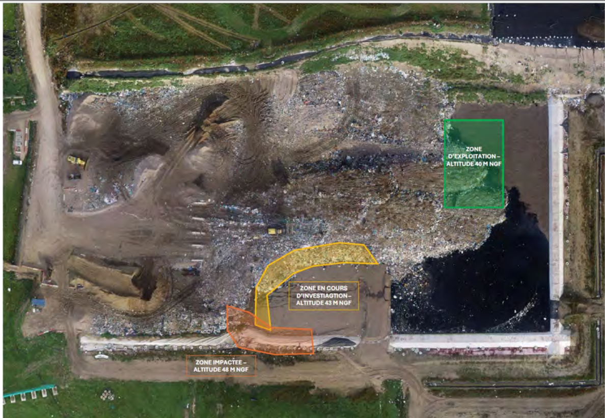
Plan de reprise d'activité (en vert), front de déchets recouvert par des matériaux (en jaune) et diguette impactée (en orange)
