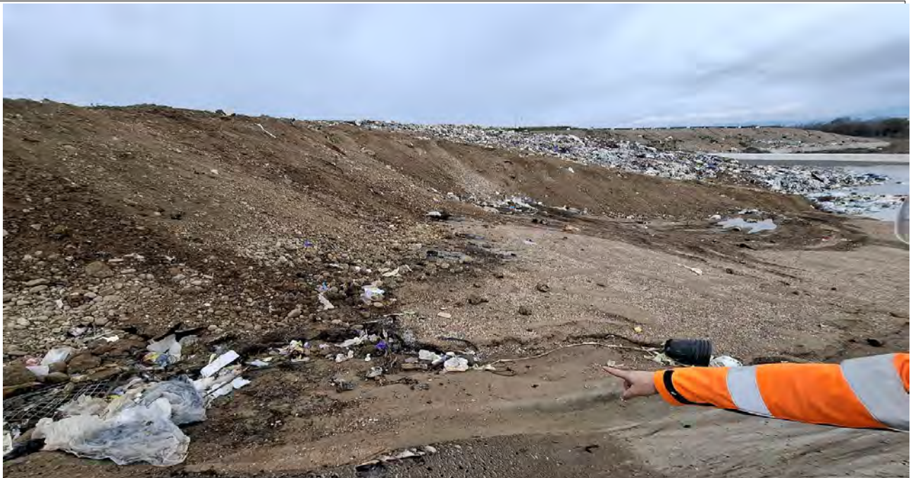
Front de déchet vertical recouvert de matériaux inertes (vue du haut du casier au sud)
