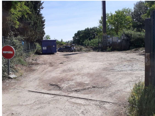
Plateforme des DV non imperméabilisée
