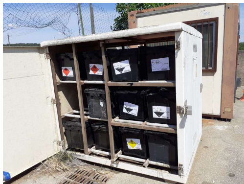
Armoire DDS non fermée
