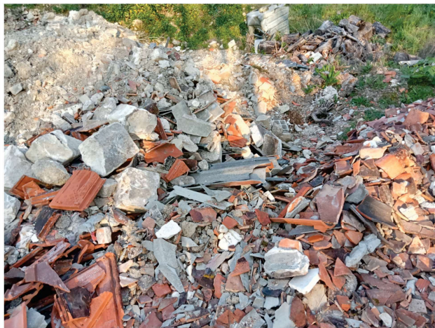
Illustration 6 : déchets amiantés en mélange avec des morceaux de plaques de fibrociment
