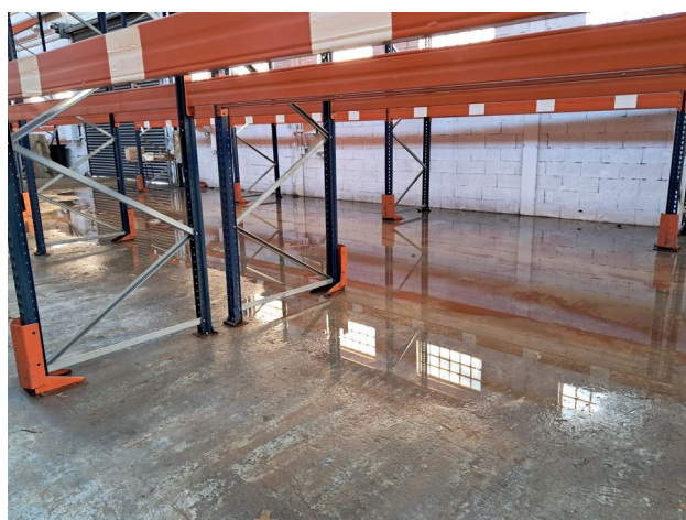
Présence de liquide côté Est de la cellule. L'exploitant indique qu'il s'agit d'eaux pluviales qui sont entrées dans le bâtiment par le quai Est (fortes pluies récentes)
