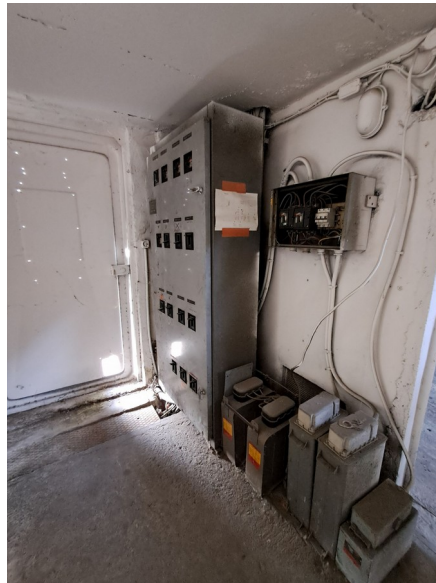
Ancienne armoire électrique sous tension dans local non fermé attenant au stockage
