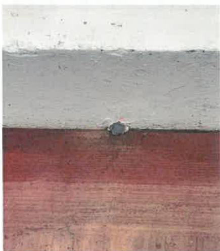
Bouchon sur l'évacuation des eaux stagnantes
