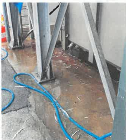
Écoulement non canalisé des jus d'égouttage de la benne de collecte des plumes
