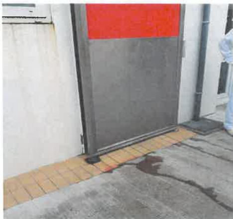
Infiltration d'eaux usées de process sous une porte débouchant sur l'extérieur
