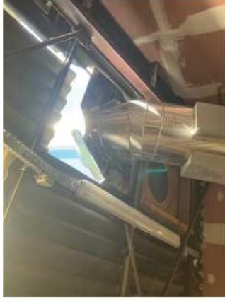
Photo n° 1 : Toit ouvert et support cheminée dégradé
