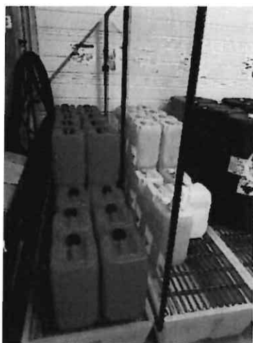
Figure 1: stockage des produits chimiques, acide dans les bidons rouges et base dans les bidons jaunes, la séparation physique est implantée entre les 2 bacs de rétention.
