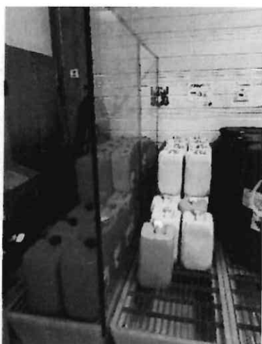
Figure 1: stockage des produits chimiques, acide dans les bidons rouges et base dans les bidons jaunes, la séparation physique est implantée entre les 2 bacs de rétention.
