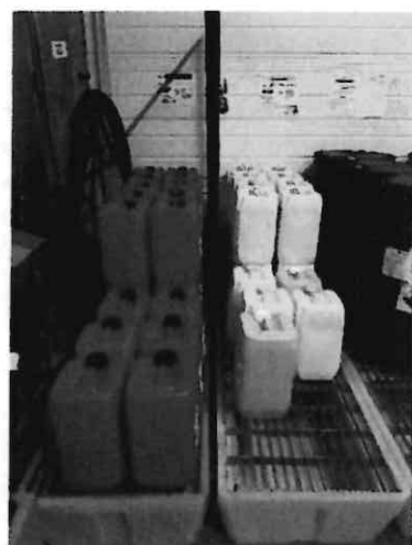
Figure 1: stockage des produits chimiques, acide dans les bidons rouges et base dans les bidons jaunes, la séparation physique est implantée entre les 2 bacs de rétention.
