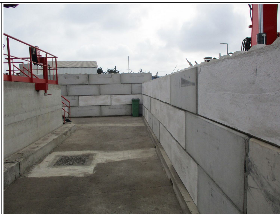
Blocs de bétons empilables utilisés comme écrans pour limiter les envols de poussières
