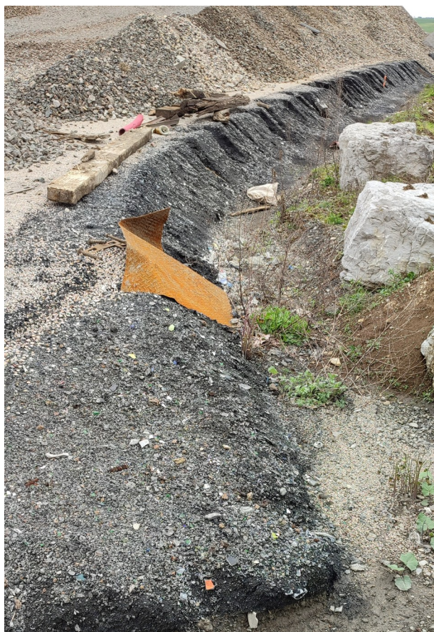
10/04/2024 : Vue prise depuis le sommet de la plate-forme constituée de couches de MIDND (à gauche) ; à droite, limite de l'ISDI. Dans le tiers supérieur, on observe des ravinements.
