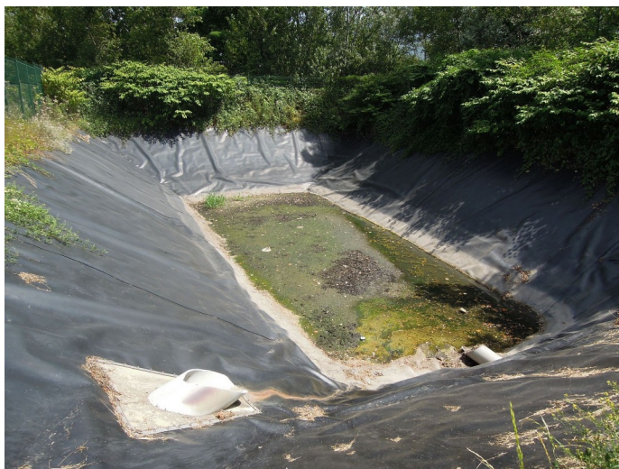
Bassin de tampon de collecte des eaux pluviales et de collecte des eaux incendie (présence importante de végétation arbustive en périphérie)
