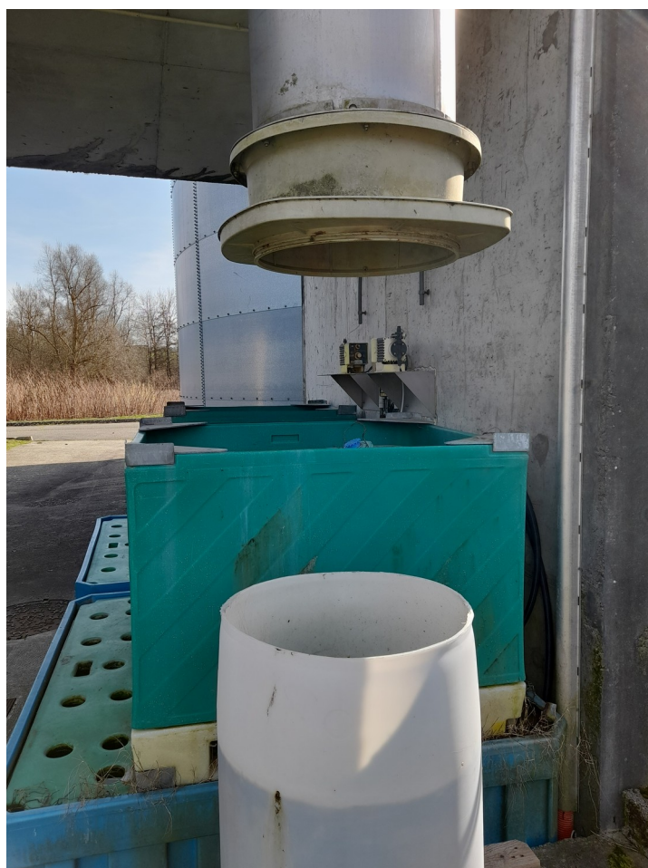
Figure 1: Fût en dessous du dégrilleur - eaux industrielles
