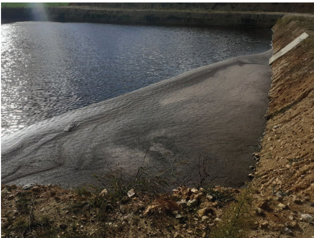
Matières en surface du bassin d'infiltration
