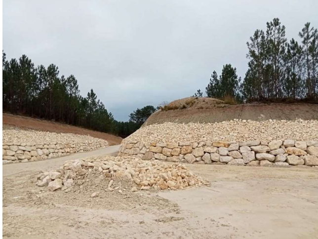
Fig. 1 Éolienne E1, enrochement de talus
