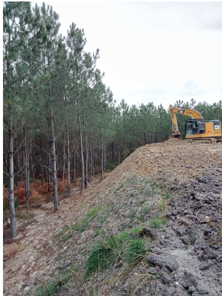
Fig. 2 Éolienne E1, talus avec forte pente à proximité immédiate d'arbres
