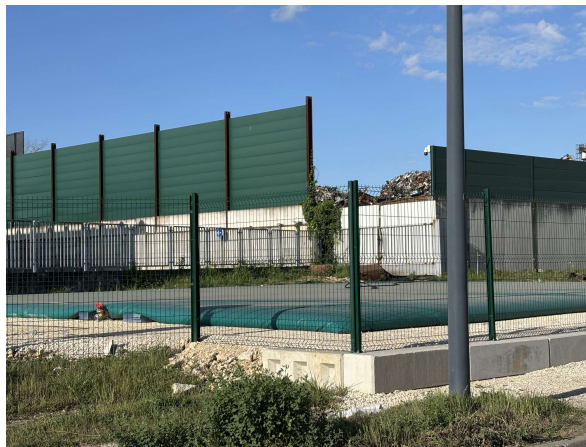
Bâche souple vidée en cours de remplissage (360 m 3 )
