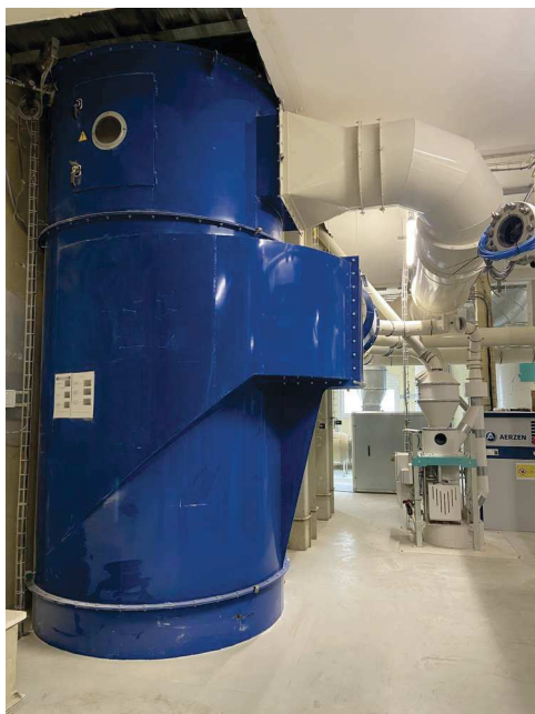
un filtre dépoussiéreur du Moulin
