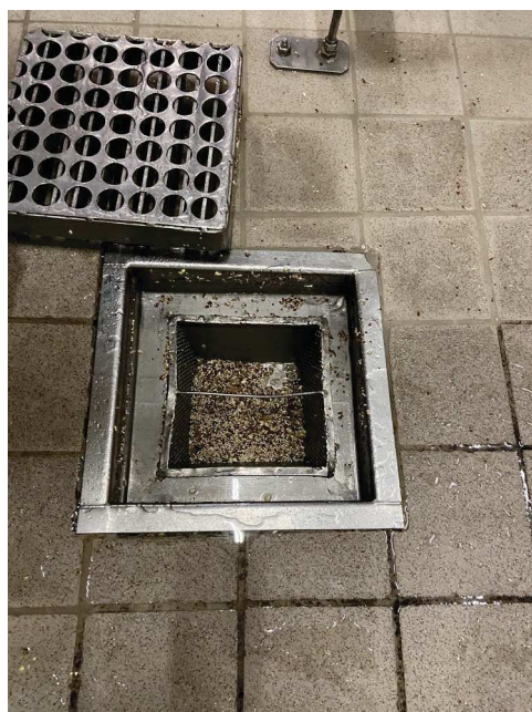
un panier dégrilleur de l'atelier PMO
