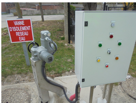
Commande de la vanne d'isolement au Nord-Est du site
