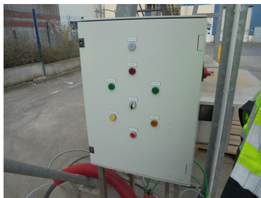
Commande de la vanne d'isolement au Nord-Ouest du site
