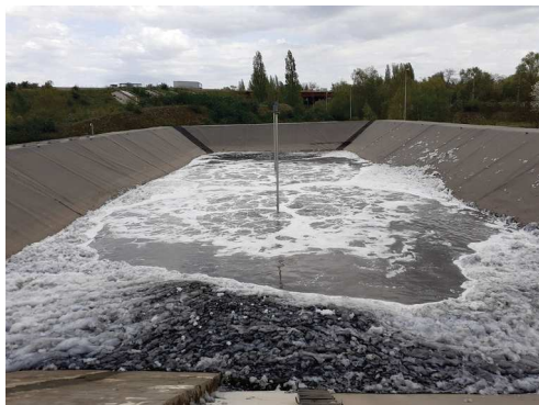
Bassin de confinement des eaux d'extinction incendie
