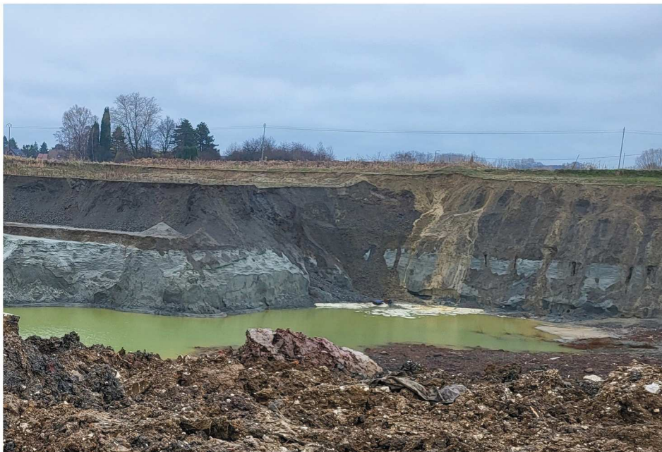
Photo 1 : Fosse nord de la carrière BDN à Templeuve présentant des fronts instables atteignant la limite du périmètre autorisé
