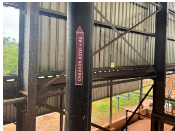
Identification des canalisations
