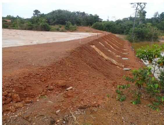
Digue avec son dispositif d'auscultation
