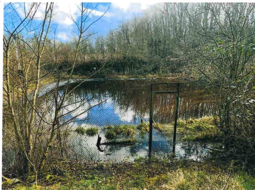
Photo n°3 : débordement du bassin de lixiviation Photos prises sur le site de la décharge le 27/02/2025.
