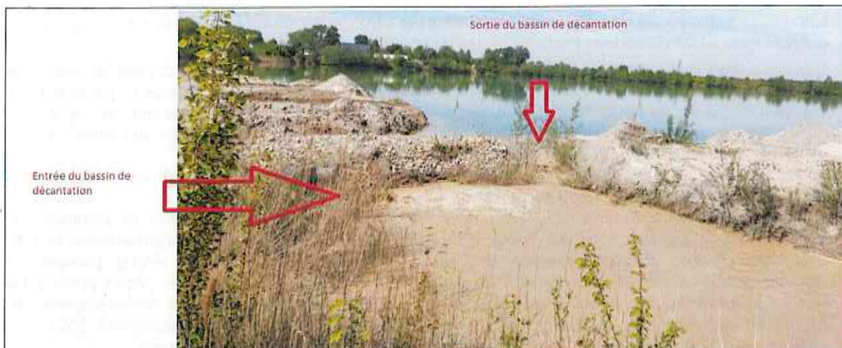
Illustration n°2 : Bassin de décantation des eaux de procédés des concassés lavés le jour de l'inspection.
