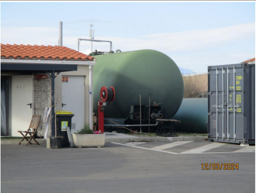
Citerne « wagon » de 110 m 3 d'eau dédiée à la lutte contre l'incendie. Au second plan on aperçoit également la citerne souple de 120 m 3 (appartenant à PMMCU) pouvant également être utilisée.
