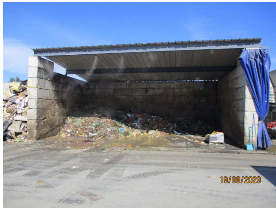
Box de réception et de tri des biodéchets muni, d'un toit, d'un rideau et d'une rampe de brumisation pour la neutralisation des odeurs
