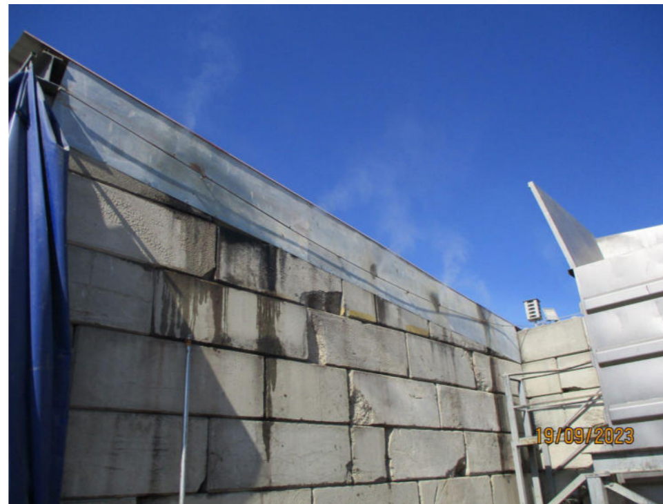
Mur de séparation du box (ci à gauche) de l'aire de travail de déconditionnement des biodéchets, muni d'une rampe de brumisation pour la neutralisation des odeurs
