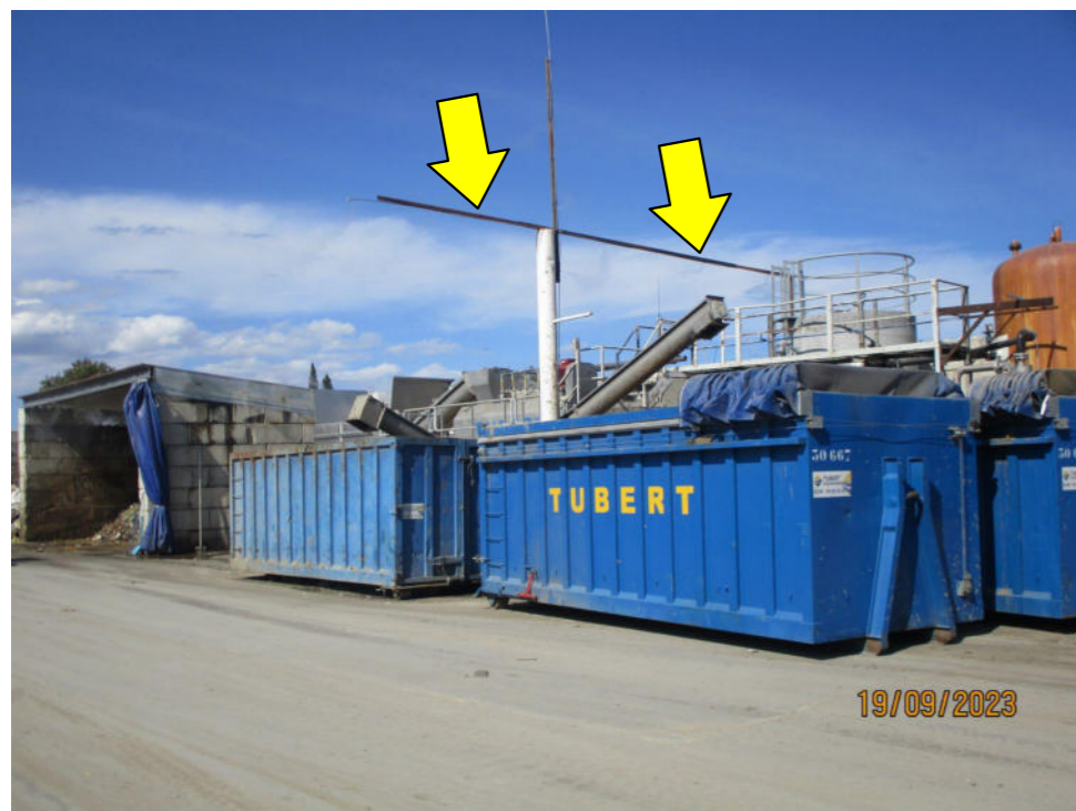
Rampe de brumisation (repérée par les flèches) installée au-dessus du déconditionneur de biodéchets, masqué par les bennes au premier plan
