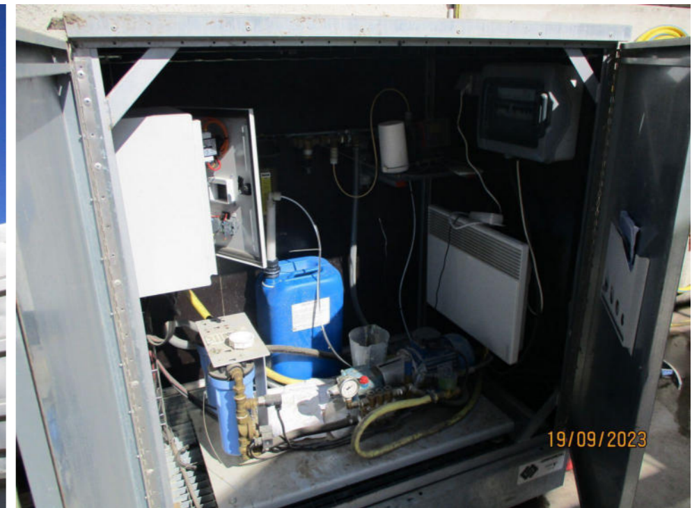
Armoire de gestion du dispositif de neutralisation des odeurs (réglage de la concentration et du débit du neutralisant)
