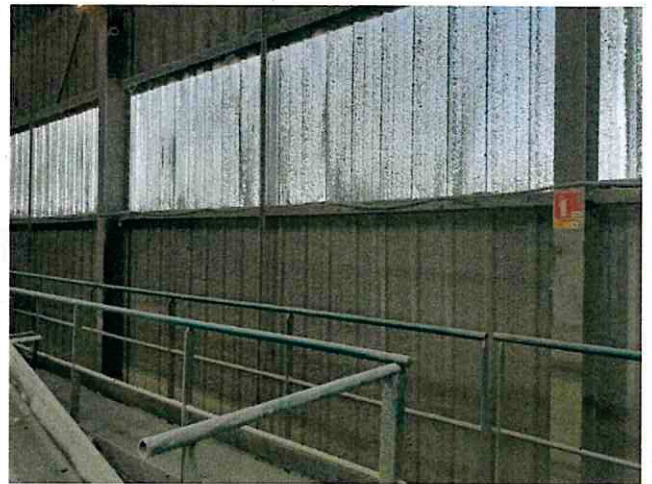
Poussières de verre déposées sur les fenêtres de l'usine
