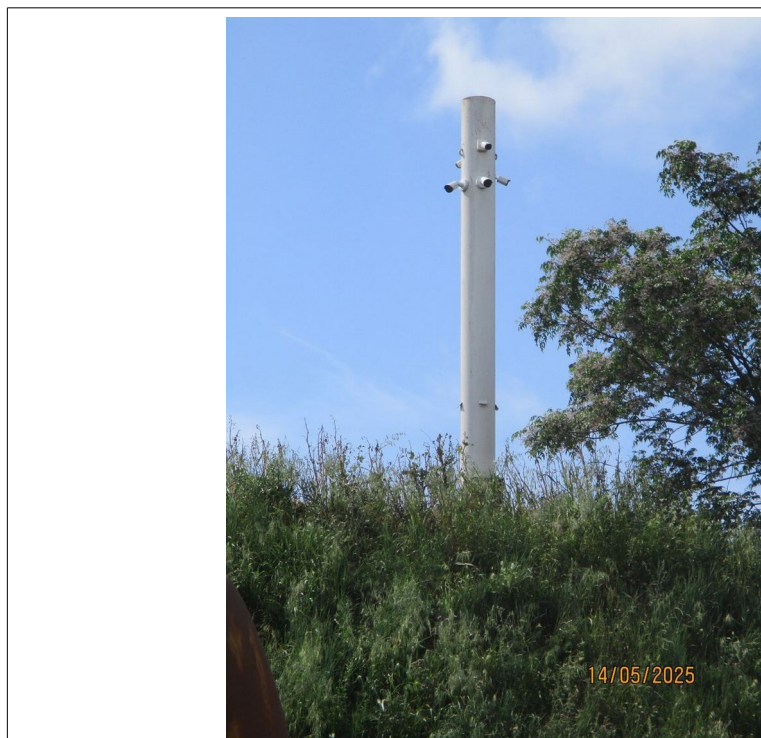
Tourelle comportant plusieurs caméras thermiques fixes
