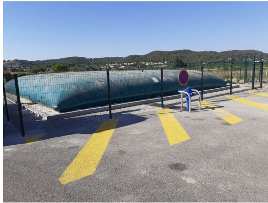
Réserve d'eau d'extinction dans bâche souple 250 m3
