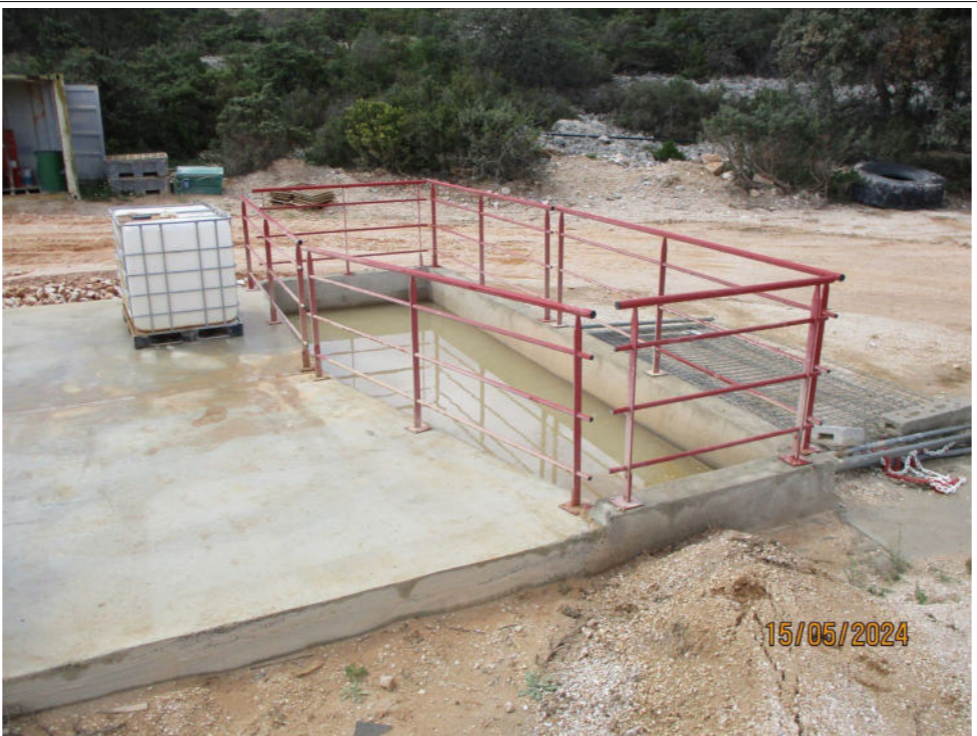
Vue du bac de décantation placé en amont du déboureur/séparateur d'hydrocarbures
