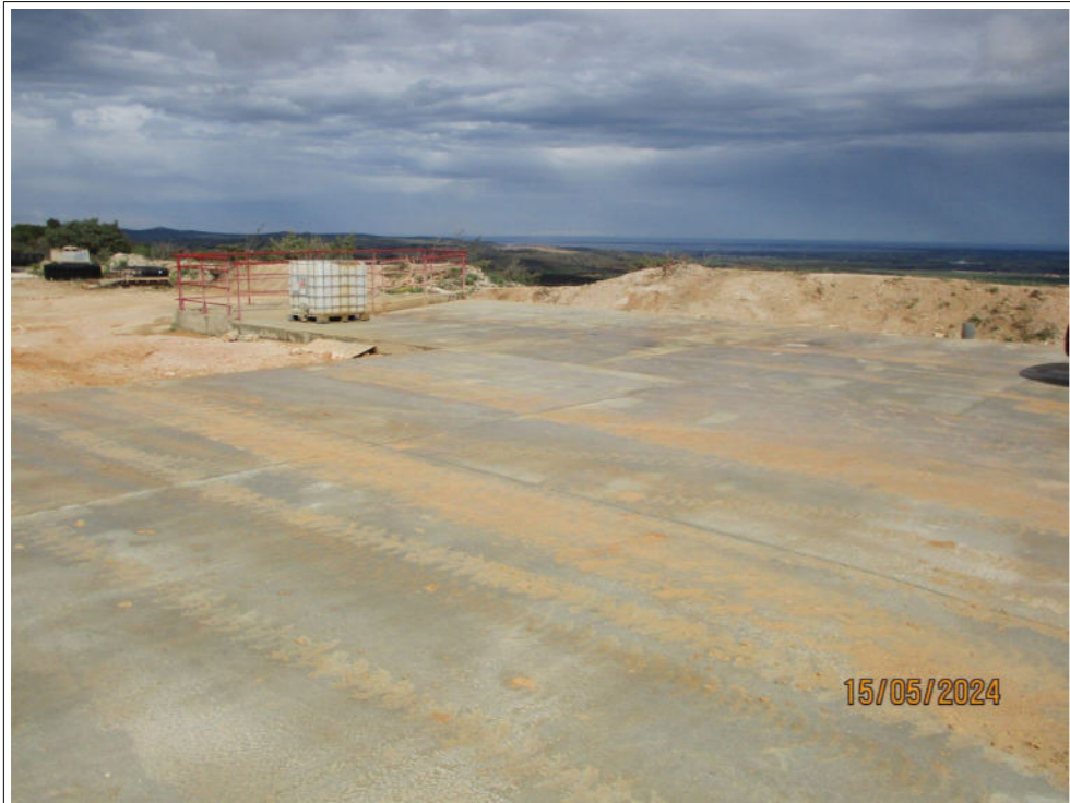
Vue de la seconde dalle (refaite) équipant l'aire dédiée au ravitaillement et à l'entretien des engins de chantier
