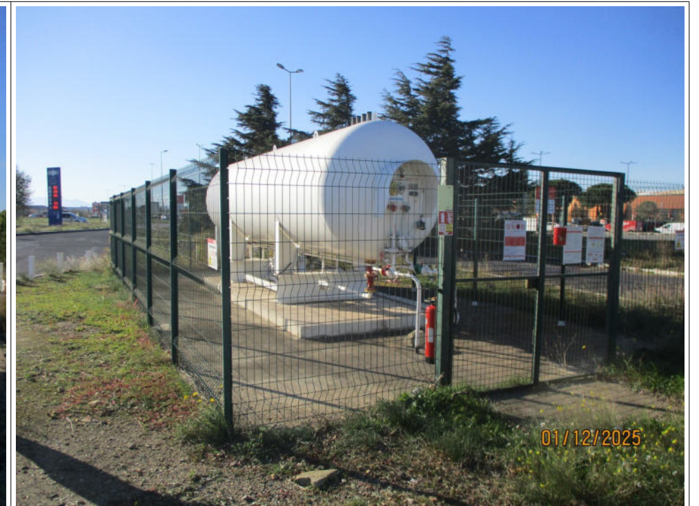
Réservoir aérien manufacturé de stockage de gaz de pétrole liquéfié
